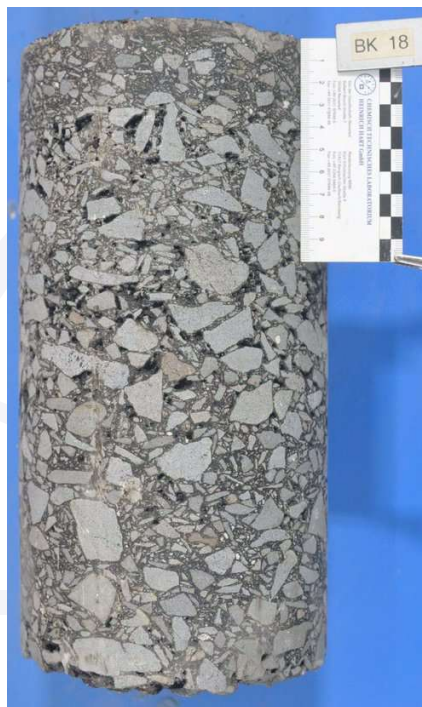
Foto des Bohrkerns
