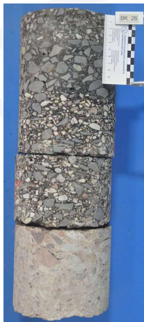
Foto des Bohrkerns
