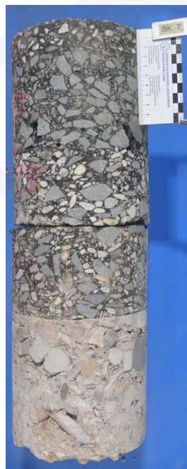
Foto des Bohrkerns
