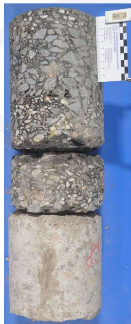
Foto des Bohrkerns
