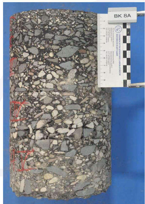
Foto des Bohrkerns
