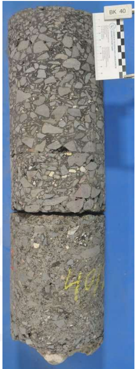
Foto des Bohrkerns
