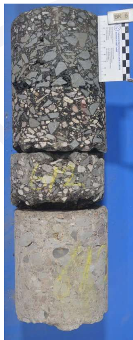
Foto des Bohrkerns
