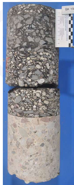
Foto des Bohrkerns
