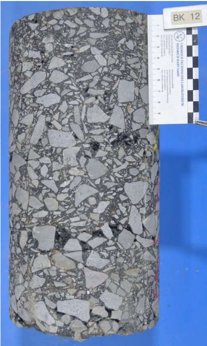
Foto des Bohrkerns
